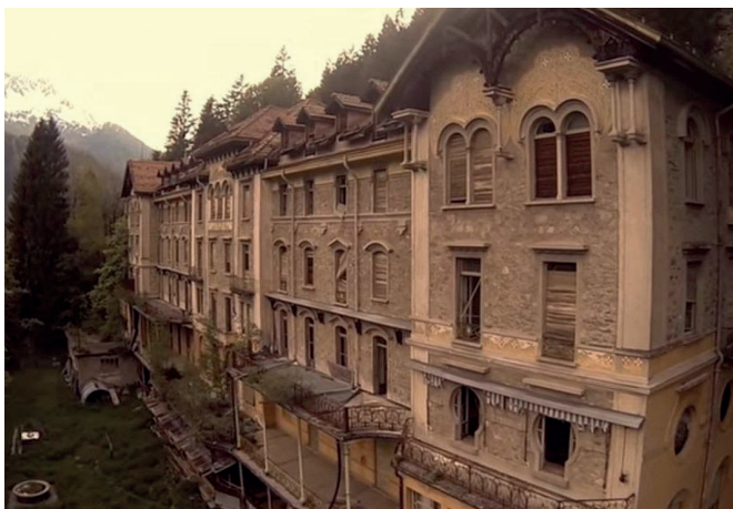
Das verlassene Kurhaus heute. Die Fenster sind vernagelt, das Gebäude verfallen.
